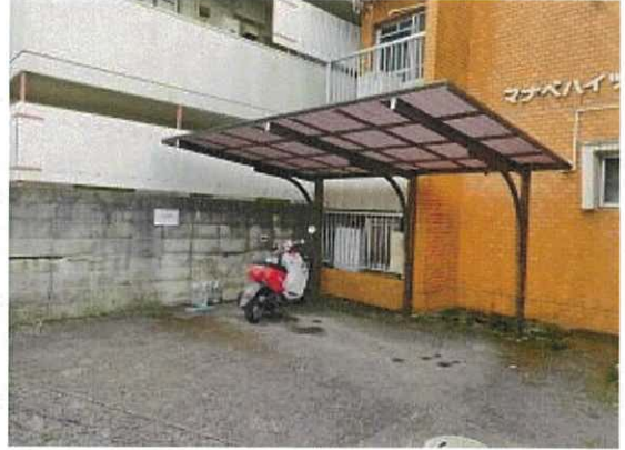
駐輪場の状況
