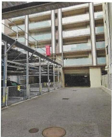
屋外機械式駐車場の状況
