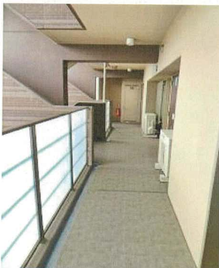
開放廊下の状況
