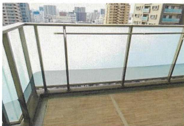
バルコニーの状況
