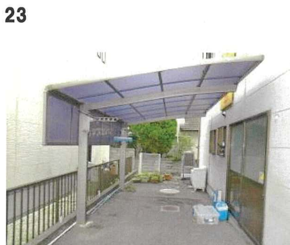
カーポートの状況
