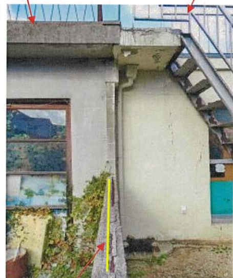
B主張の境界線（ブロック塀の中心）
