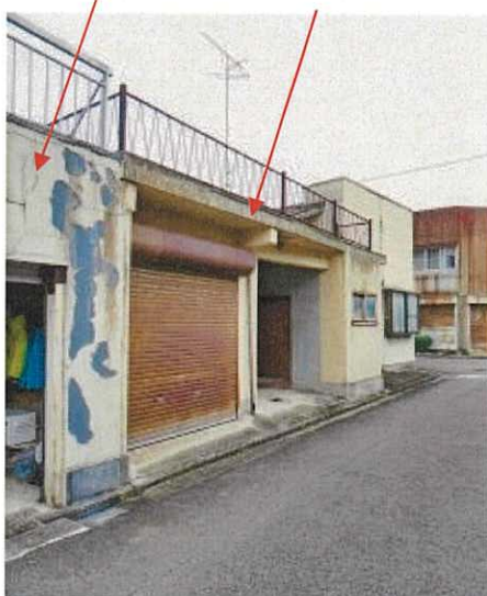
24-1の建物 物件5建物
