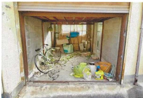
駐車場の状況
