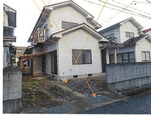
② 物件 5 物件 7 物件 1 水路上のコンクリート橋
