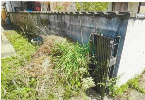
北東側ブロック塀の状況
