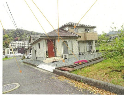
② 物件1 物件2南西側部分 北東側部分 市道 水路
