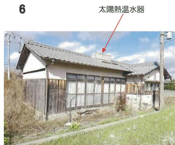
以下、物件3建物の状況
