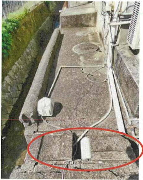
東側隣地からの浄化槽の配管の状況 目的外建物
