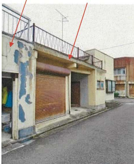
24-1の建物 物件5建物
