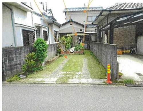
② 地番541番14の土地 物件2 はみ出している差し掛け プロパンガスの容器
