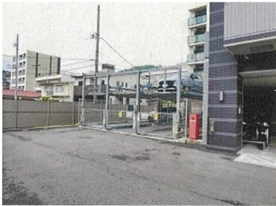
機械式駐車場の状況
