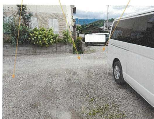
⑥ 物件2 水路（暗渠部分） 物件1
