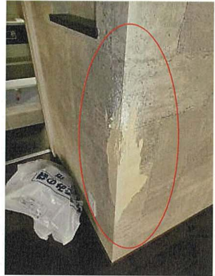
内壁の損傷状況
