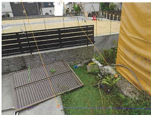
③ 物件2 地番1067番15の土地上の土間コンクリート
