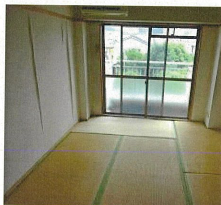
303号室（空室）の状況
