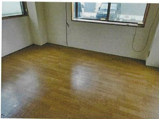
105号室（空室）の状況
