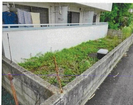
物件1 土地の東側部分の状況
