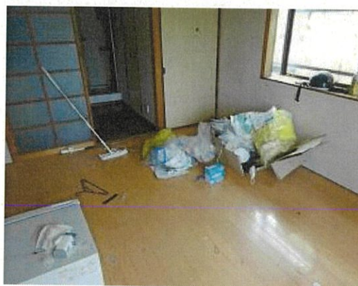
201号室（空室）の状況
