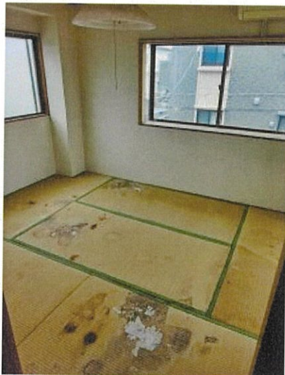
305号室（空室）の状況
