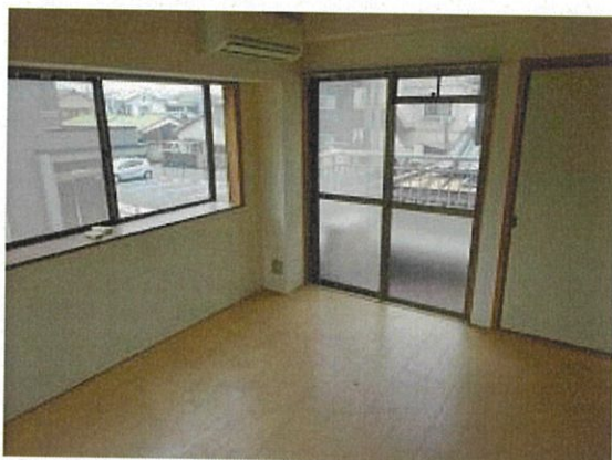
205号室（空室）の状況
