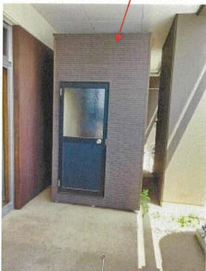
未登記 附属建物（倉庫）の状況
