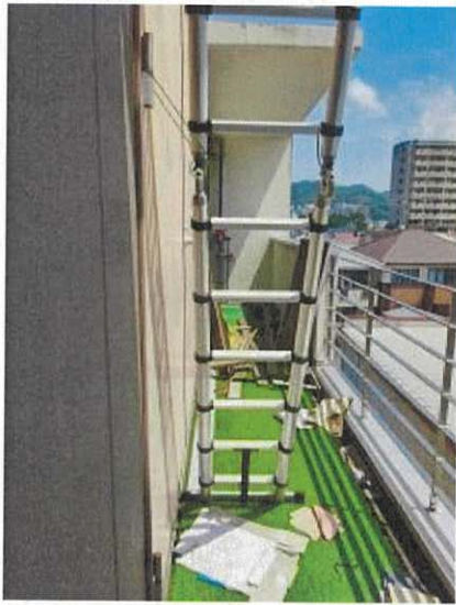
バルコニーの状況
