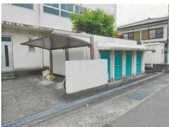
附属建物（符号2）ゴミ置場の状況
