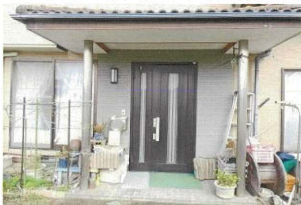
玄関付近の状況
