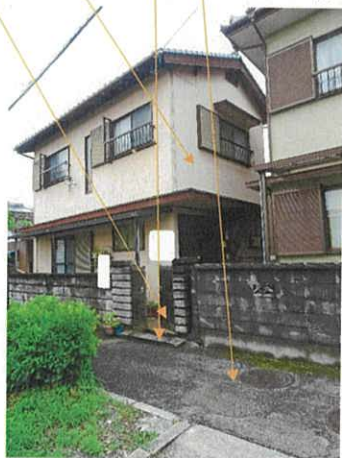
① 物件2 農道 物件1 門扉北側のステップ部分
