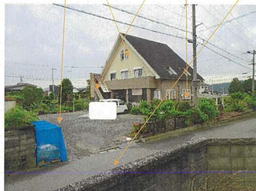
④ 地番2015番9の土地 物件1 市道 家屋番号2015番8の建物、同建物の外階段
