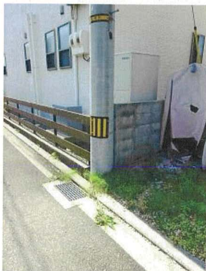
一部敷地内電柱の状況
