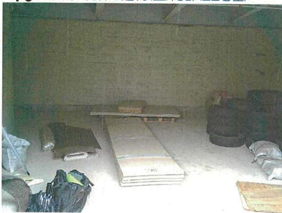
19 以下, 物件8建物(主)内部(22号室)
