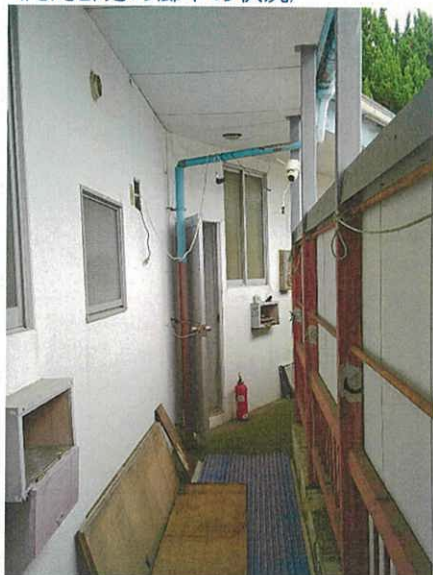
25 (内周部分の廊下の状況)
