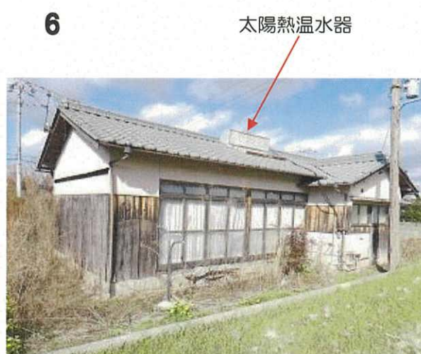
以下、物件3建物の状況
