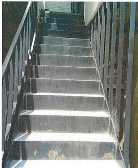
7 以下、物件2建物内部
