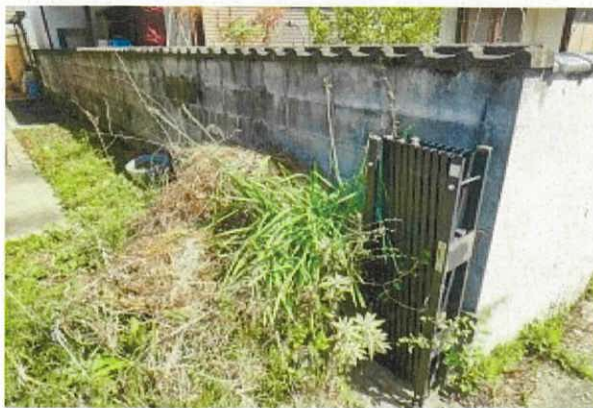
北東側ブロック塀の状況
