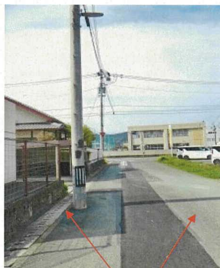
接面道路の状況
