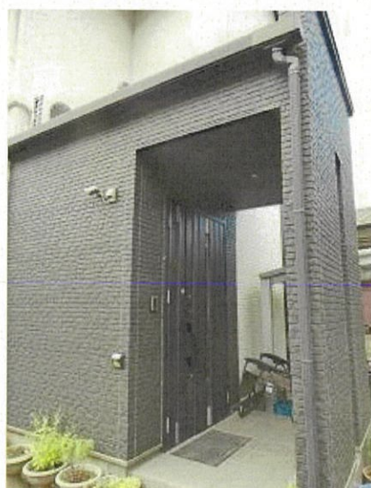
玄関付近の状況
