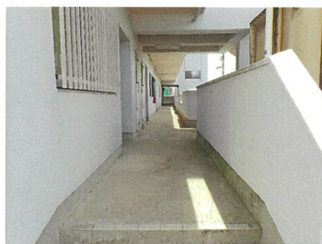
⑥ 1階廊下（共用部）
